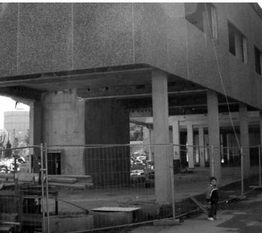
*Die Fassadenwände des „Krokodil“ sind entfernt und die Abflussleitungen gelegt.*
